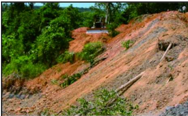
Gambar 1. Valley Fill atau Crest Dump (Bargawa,2018)
