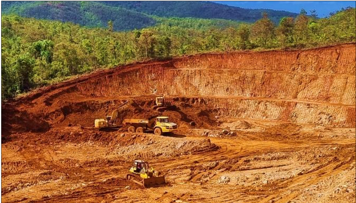
Gambar 1. Progres penambangan di Front Jeddah
