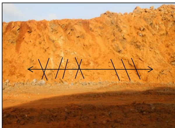
Gambar 7. Kondisi Scanline Pada Lereng Arafa III
