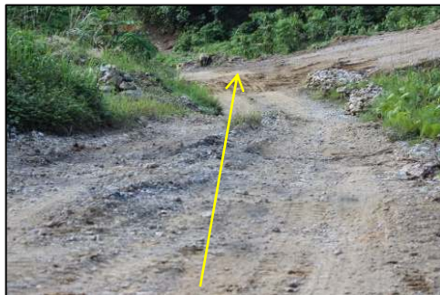
Gambar 4. Kemiringan Jalan Segmen A-B
